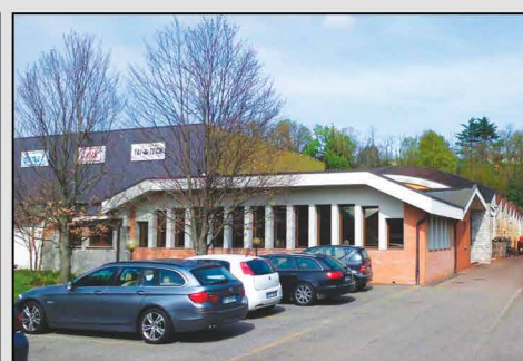
Stabilimento di Turbigo - Turbigo plant
